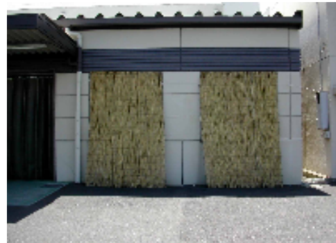
日除けの為に、よしずを設置 (直射日光や反射熱を防ぎます)
